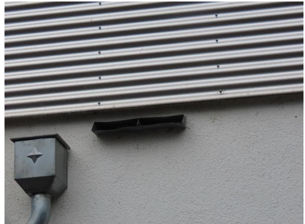
Abb. 16: Lüftungsschlitze in der Fassade
