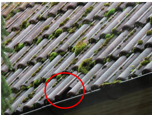
Abb. 17: Beschädigte Dachziegel
