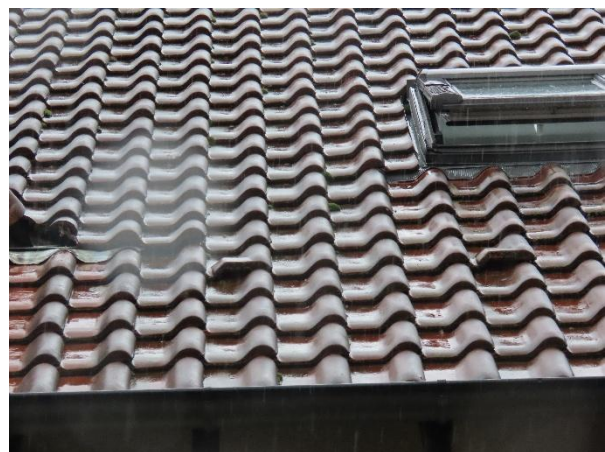
Abb. 18: Offene Lüfterziegel am Schaftrieb 9
