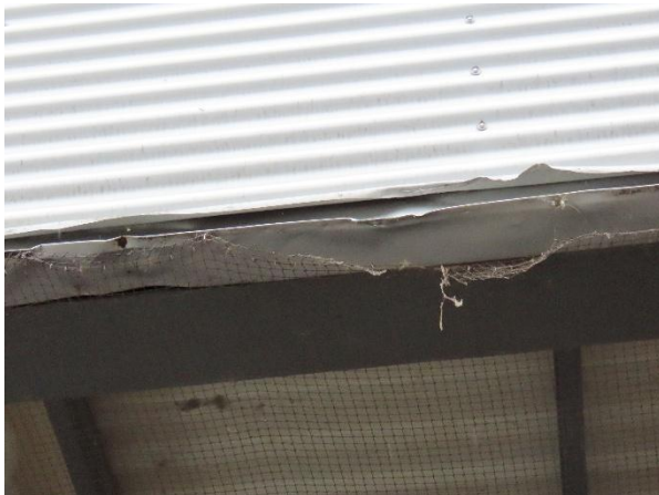
Abb. 15: Spalt in Wellblechverkleidung
