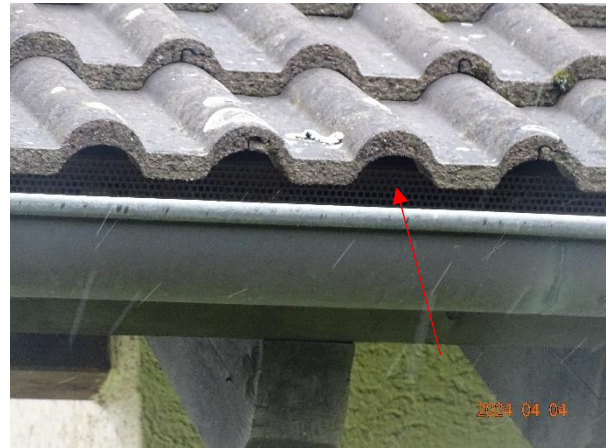
Abb. 8 Gitter im Traufbereich unter den Ziegeln am Gemeindesaal (roter Pfeil)
