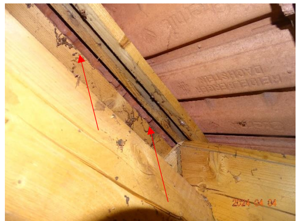
Abb. 18: Spalt am Dachfirst der Garage (rote Pfeile)
