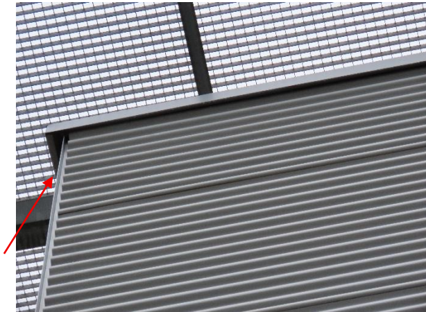
Abb. 13: Spalt in südlicher Wellblechverkleidung Sulzbacher Straße 140
