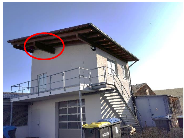
Abb. 14: Gebäude mit Holzbalken Sulzbacher Straße 168/1
