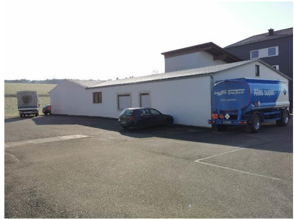
Abb. 12 Gebäude mit Wellblechdach Sulzbacher Straße 168/1
